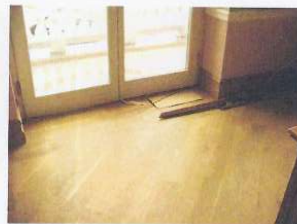
nieszczelności drzwi balkonowych
