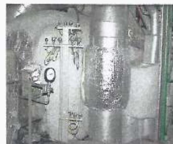
wady w izolacji turbiny parowej
