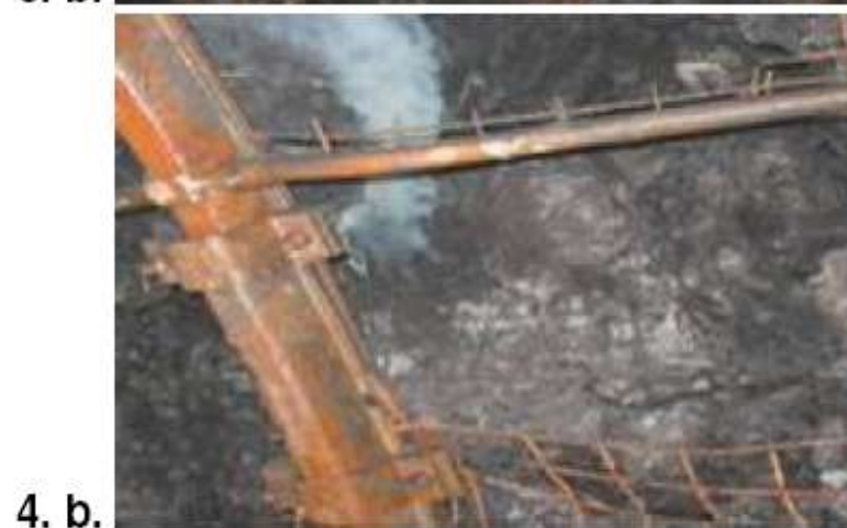
Fot. 3a; 4a. Strefy z wysoką temperaturą w ociosie wyrobiska chodnikowego
